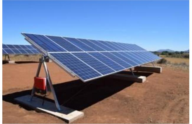
*Figura 22. Seguidor un eje. Deger Iberica*
